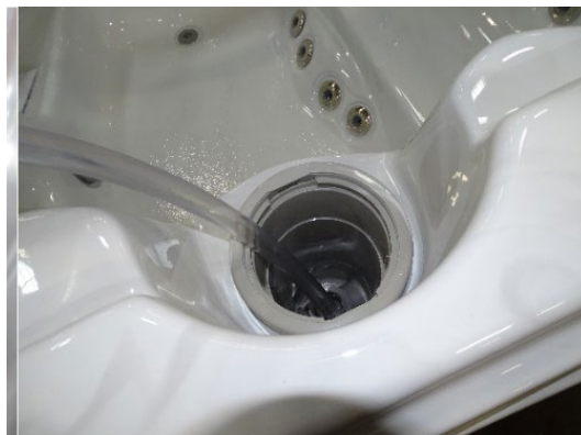
Ovan bild. Filter urtaget och slang för fyllning av badet i filterhållaren
