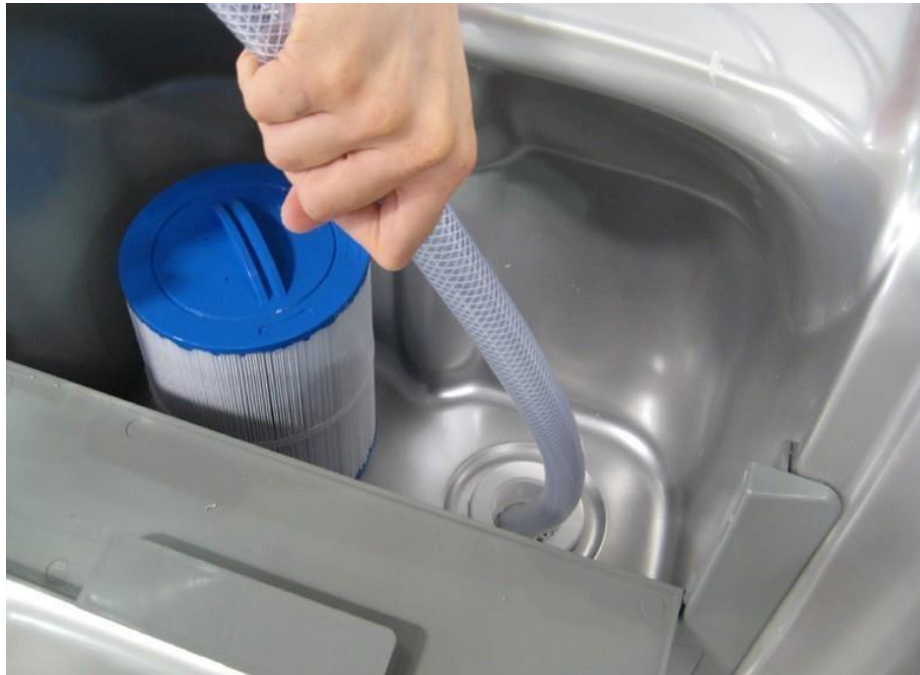
Bild 2. Påfyllningsplats i filter huset
